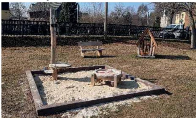
Auch hier musste zunächst die Fläche für den Sandkasten ausgekoffert werden. Dann wurden die einzelnen Elemente einbetoniert und der Spielsand aufgefüllt. Ergänzt wird dieses Ensemble durch eine Bank.
